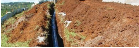
Kanal/rov za cevovod (Shute Pipeline)
